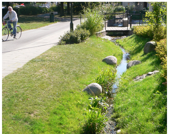
Mynd 5 Tvær mismunandi útfærslur gróðursælla ofanvatnslausna sem færa græna netið inn í göturýmið.
