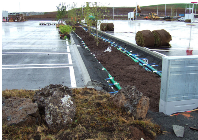
Mynd 17 Blágrænar ofanvatnslausnir í Kaupþúni, Garðabæ, á framkvæmdartíma.
