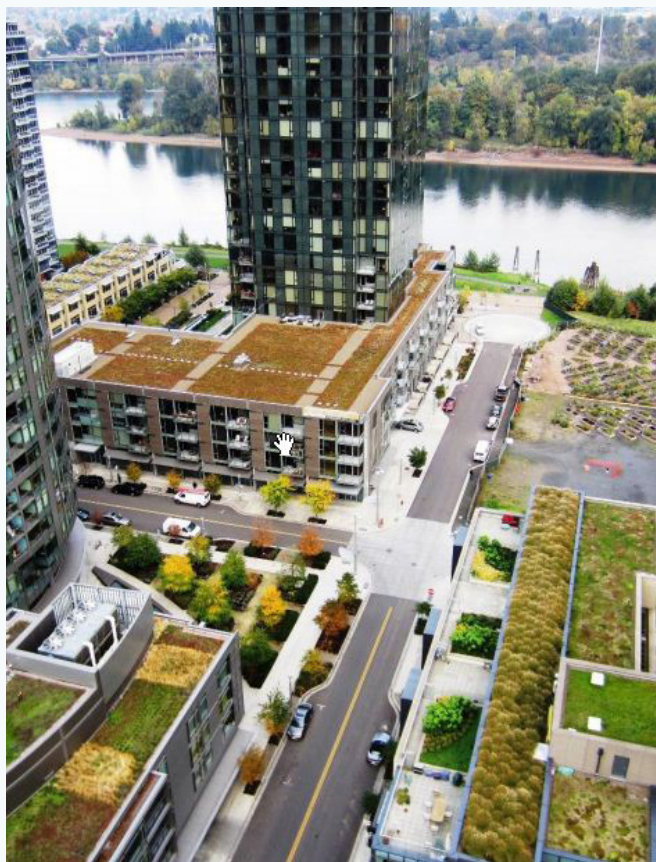
Mynd 29 Græn þök eru mikilvægur hlekkur í blágrænum ofanvatnslausnum í Portland - og sífellt bætast fleiri við (Ljósmynd: Portland, Oregon).
