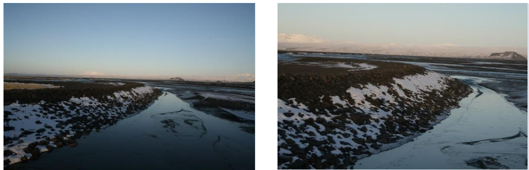
Mynd 7.2 Varnargarðar við brú á Markarfljót áþekkir þeim sem byggður verður í árfarvegi.
