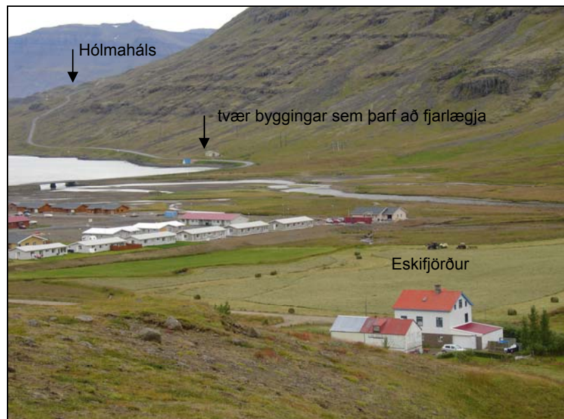
Mynd 3.2.3. Útsýni yfir mögulegt framkvæmdasvæði frá vatnstanki ofan Eskifjarðar (Ljósmynd: Sóley Jónasdóttir, ágúst 2007).
