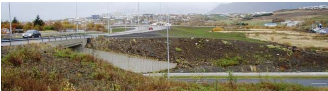
Mynd 3-1 Horft yfir veggöng á Krókhálsi að vegamótum Vesturlandsvegur.
