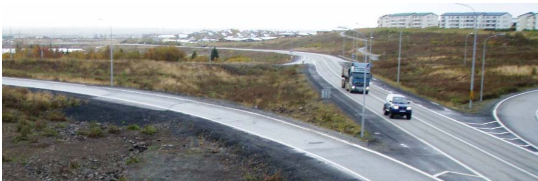
Mynd 3-2 Vegamót við Bæjarháls, horft af brú til suðurs. Aðlaga þarf að- og fráreinar.
