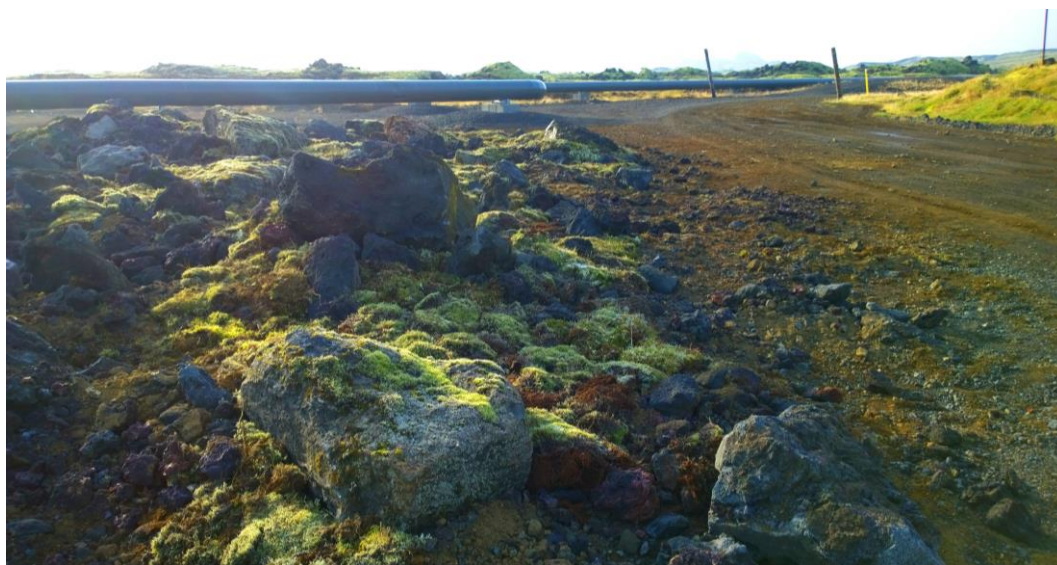
Mynd 7.4 Dæmi um endurheimt hrauns og mosapembu á borplan við Hellisheiðarvirkjun. Hraungjalli og hraunsteinum er komið fyrir og mótað í samræmi við umlykjandi landslag. Mosatorfum og lausum mosa, sem haldið var til haga í upphafi framkvæmda, er komið fyrir í hraungjallinu til endurheimtar á mosapembum.
