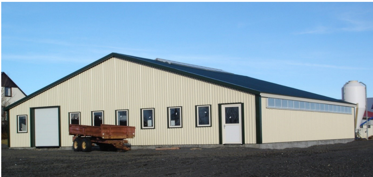
MYND 3.2 Stálgrindahús með fóðursíló við gáfl. Mynd: Landstólpi
