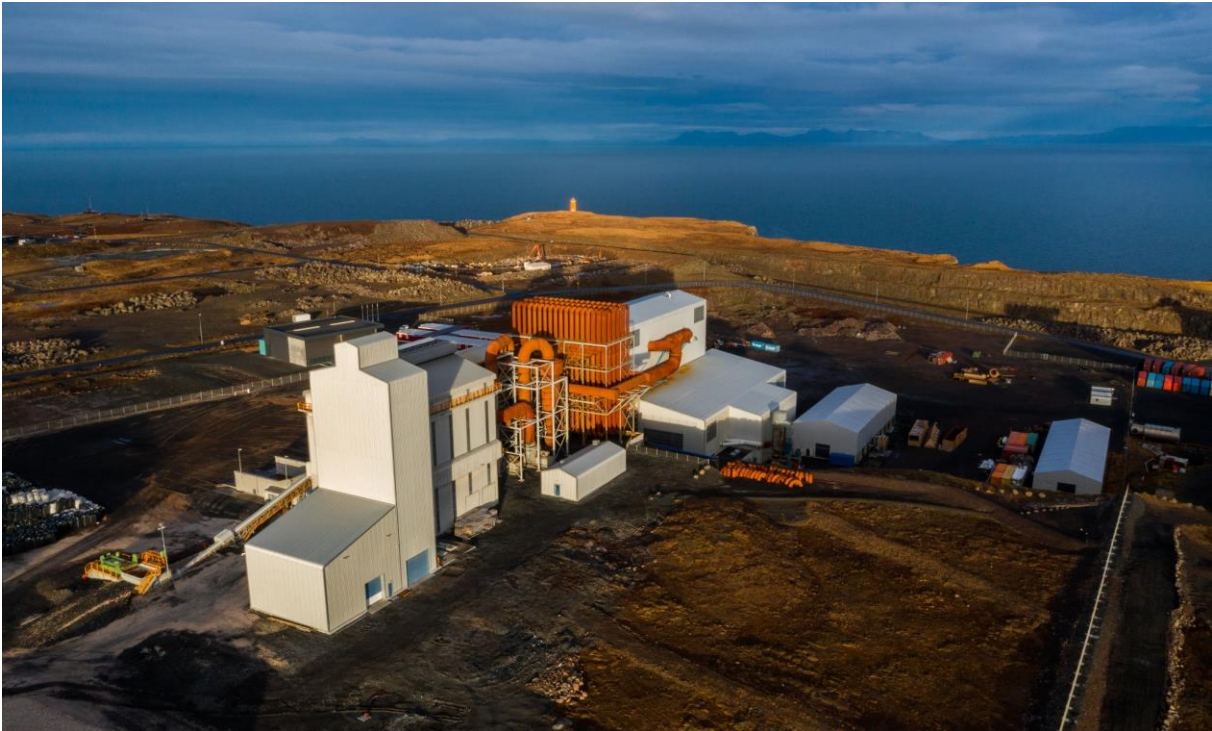
Mynd 5.3 Núverandi mannvirki verksmiðjunnar, horft úr lofti til norðausturs. Mynd Hörður Kristleifsson, nóv. 2018.
