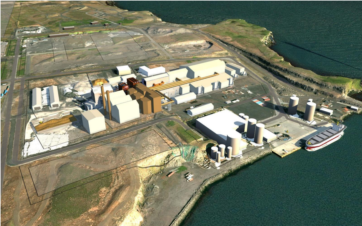
Mynd 5.6 Líkan af fullbyggðri verksmiðju með 4 ofna. Einnig sést líkan af núverandi mannvirkjum á öðrum lóðum við höfnina í Helguvík. Líta ber á mannvirki framtíðaráfanga sem skematíska framsetningu á áætlaðri stærð þeirra. Framtíðarbyggingar eru sýndar í hvítum lit en búnaður sem yrði úr stáli, s.s. loftkælar, forskiljur og skorsteinar, sýndur í brúnum lit.
