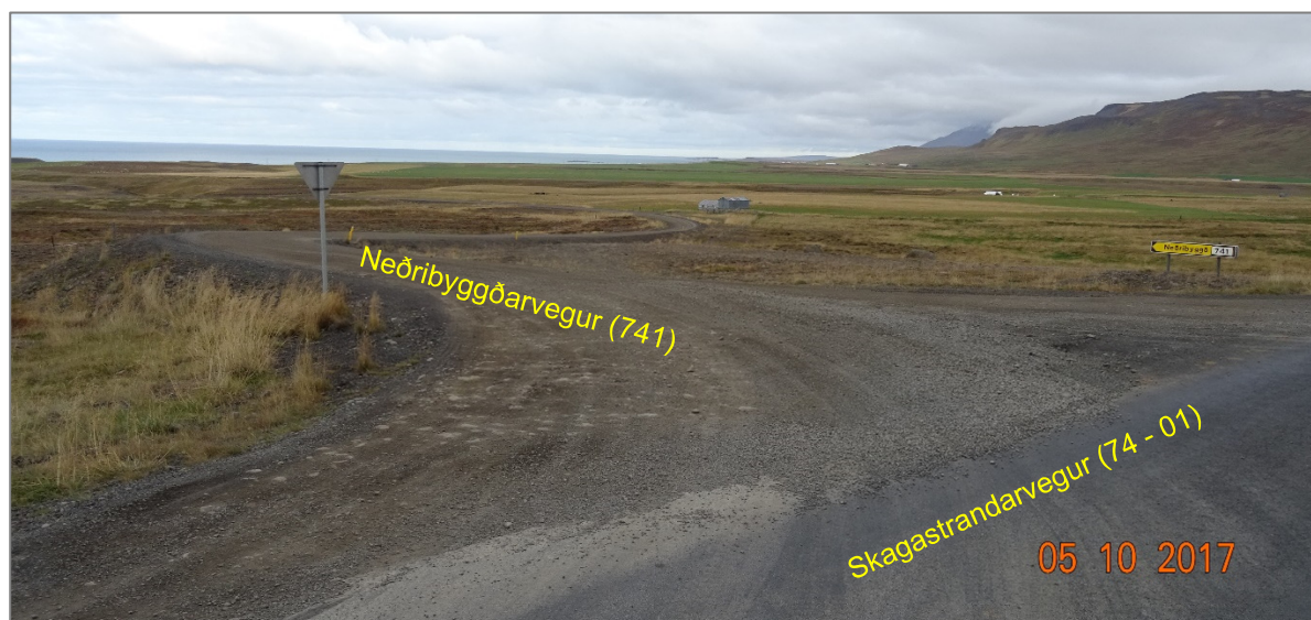
Mynd 2.2.3. Vegamót Neðribyggðarvegur (741) og Skagastrandarvegur (74 - 01) hjá Neðri Lækjardal (ljósmynd: Sóley Jónasdóttir, 2017).
