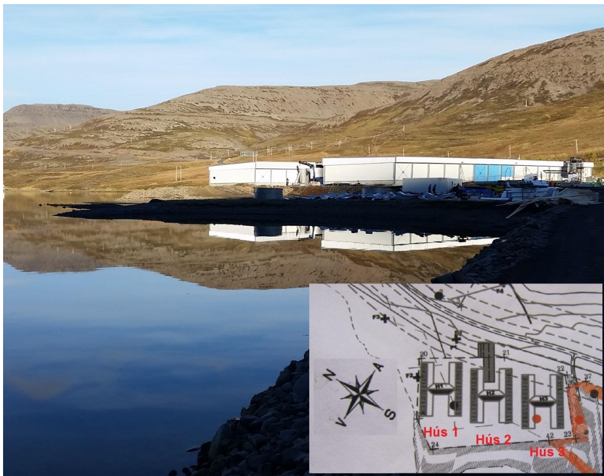
Mynd 4-1 Seiðaelisstöð fyrirtækisins Arctic Smolt ehf. í byggingu í Tálknafirði. Seiðastöðin samanstendur af þremur húsum sem hvert um sig er 3.000 m 2 og kerjarými innanhús verður samtals 8.400 m 3 . Lokið er að mestu byggingu á einu kerjahúsi (hús 1) og annað hús er langt komið (hús 3). Myndin sýnir fyrsta húsið sem þegar er komið í notkun og Hús 3 er að hluta komið í notkun. Innföld mynd sýnir staðsetningu eldisstöðvarinnar, neðan þjóðvegur í botni Tálknafjarðar.
