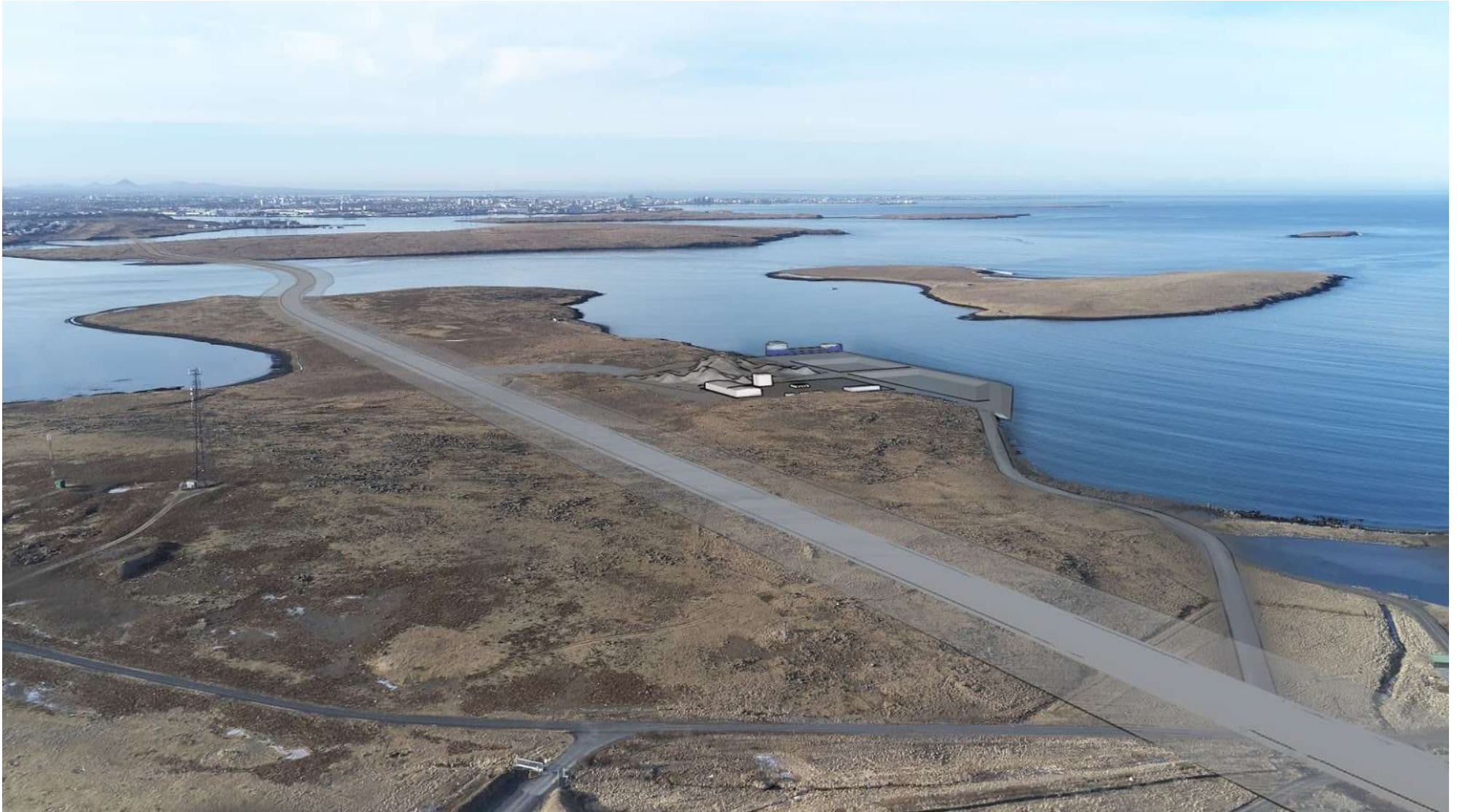
Mynd 3.19: Möguleg útfærsla á lóð Björgunar sýnd á loftmynd ásamt svæði sem er tekið frá í aðalskipulagi fyrir framtíðarlegu Sundabrautar. Valið er að bæta Sundabraut inn á mynd frá þessu sjónarhorni því það gefur besta yfirsýn yfir svæðið og sýnir vel nálægðina milli Sundabrautar og framkvæmdasvæðisins.
