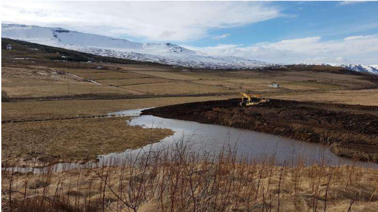
MYND 5.3 Jarðvegslosun á framkvæmdasvæði. Horft til vesturs, að vetri til. Mynd: Akureyrarbær.
