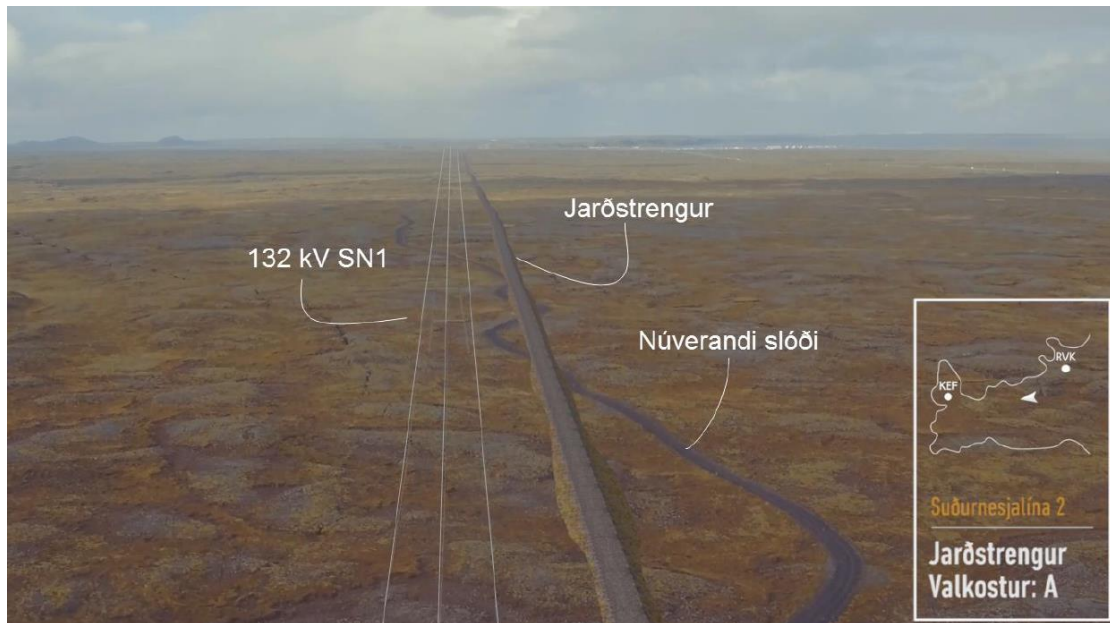
Mynd 5: Mynd 25 Möguleg útfærsla á jarðstreng samsíða Suðurnesjalínu 1 þar sem slóði er lagður að hluta yfir jarðstreng i verklok (Landsnet, 2016).
