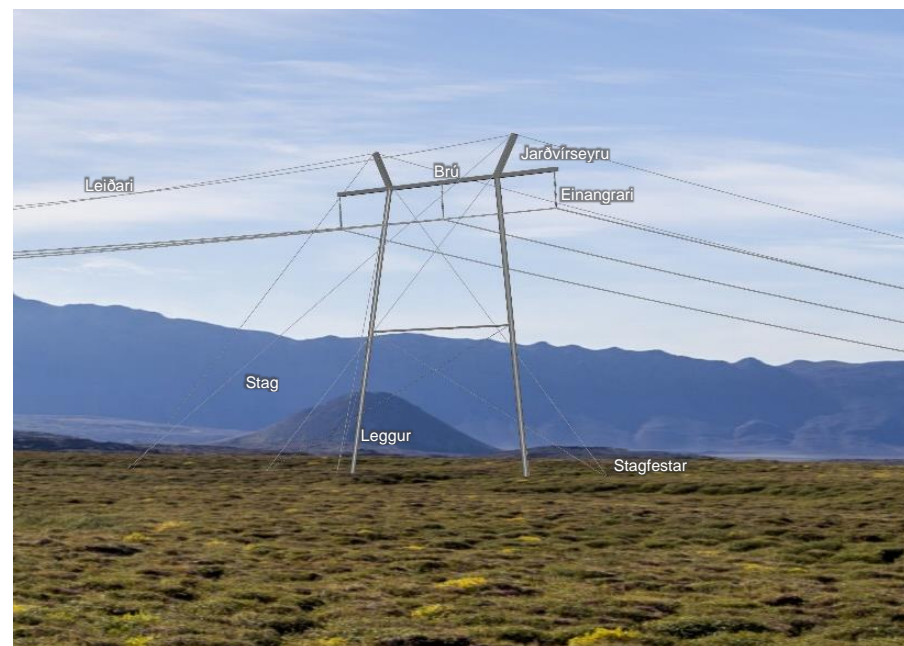
Mynd 5.1 Stagað röramastur með jarðvírseyrum. Helstu hlutar masturs. Efst er brú og millipverslá fyrir miðju sem styður við leggi.
