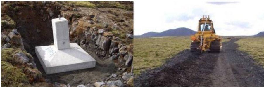
Mynd 5.3 Til vinstri má sjá forsteypta undirstöðu masturs og til hægri sést hvernig jarðskaut er plægt í kant á vegslóð.
