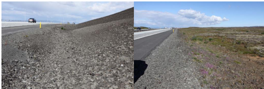
Mynd 6.13 Vegfláar Reykjanesbrautar og skeringar
