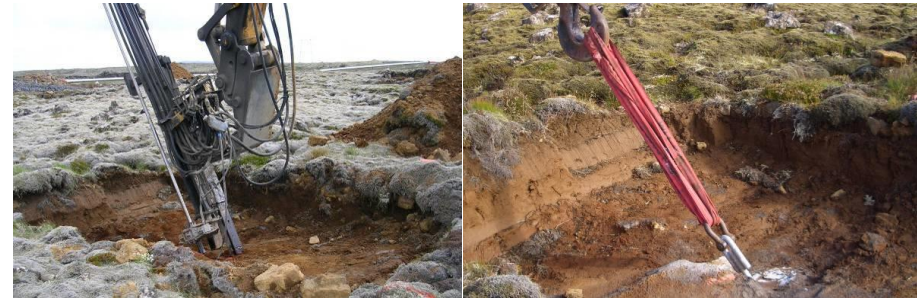
Mynd 5.4 Til vinstri sést hvar borað er fyrir bergbolta. Myndin til hægri sýnir prófun á bergbolta. Þar sem dýpra er á fastan botn er nemur meira en 1,5 m eða ef klöpp á því dýpi er talin léleg fyrir bergbolta, er komið fyrir forsteyptri staghellu á viðeigandi dýpi og síðan er hæfilega þungu aðfluttu fyllingarefni komið fyrir ofan á hellunni til að nægilegt hald fái í stagfestuna.
