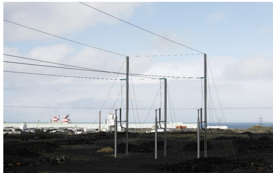
Mynd 6.19 Líkanmynd af strengendamastri svipuðu og gert er ráð fyrir að risi við Hraunhelli.
