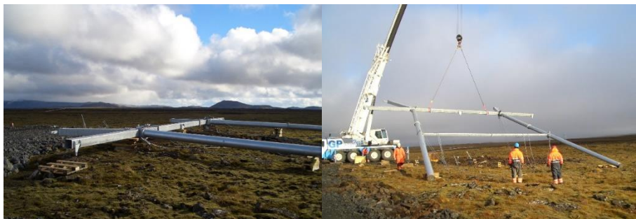
Mynd 5.7 Myndin vinstra megin sýnir samsett mastur. Hægra megin sést kranabíll reisa mastríð. Myndirnar eru úr línunni á milli Reykjanesvirkjunar og aðveitustöðvar við Rauðamel.
