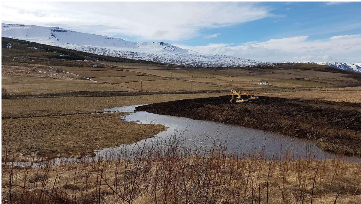
MYND 5.3 Jarðvegslosun á framkvæmdasvæði. Horft til vesturs, að vetri til. Mynd: Akureyrarbær.
