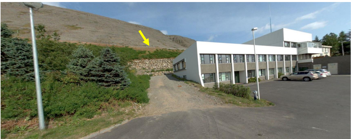
Mynd 10.27 Þvergarður við Klíf, en framkvæmdum við hann er lokið. Mynd tekin af ja.is.
