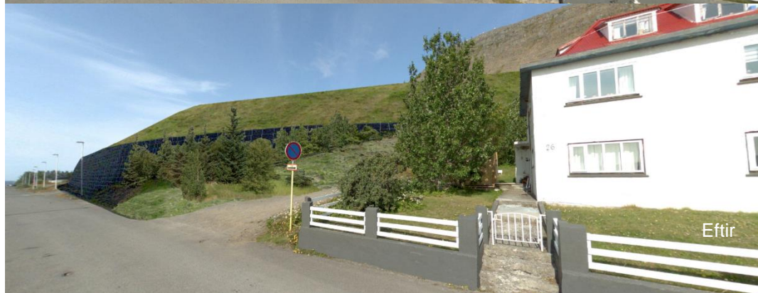
Mynd 10.22 Möguleg ásynd Urðargarðs, séð frá Urðargötu 26. Myndirnar sýnir núverandi ásynd og ásynd eftir að varnargarðar hafa verið byggðir. VSÓ Ráðgjöf.
