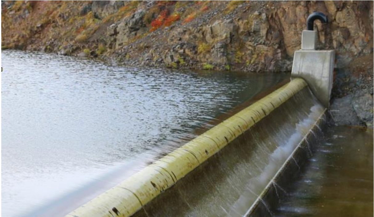
Mynd 2.6 Ljósmynd af Coanda-inntaki sambærilegu því sem áætlað er að nota á Gönguskarði.
