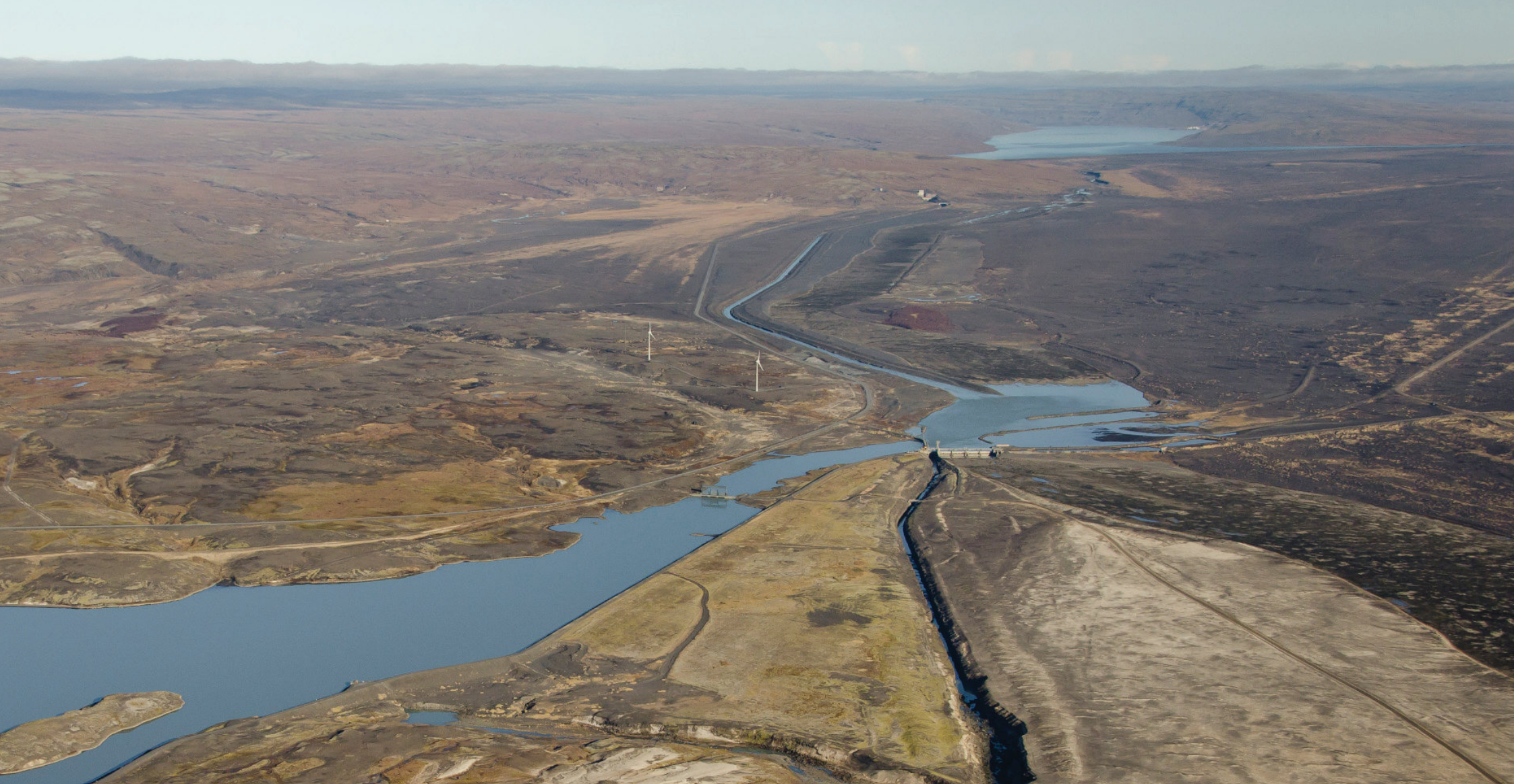
Mynd: Horft til norðausturs í átt að Sultartangalóni, fyrir miðri mynd er veitumannvirki Búrfellsvirkjunar og núverandi rannsóknarvindmyllur.
