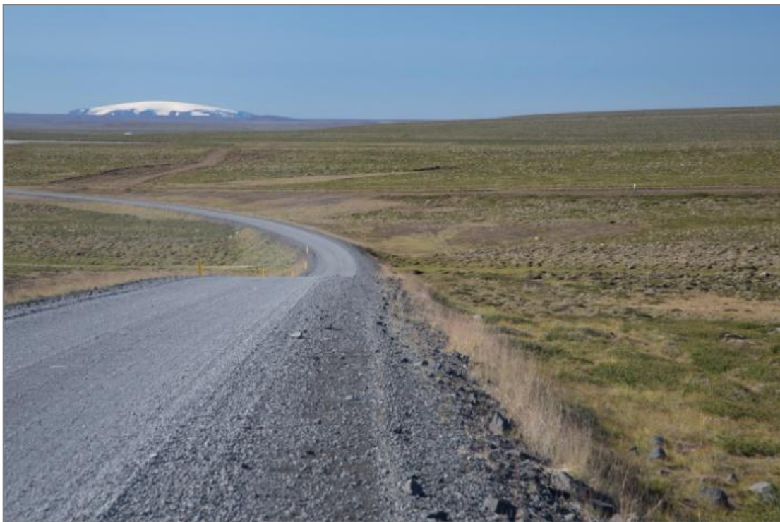
Mynd 10 a og b, Staðsetning efnislosunarsvæðis nr. 6 og hlykkur á vegi þar sem tilfærsla og hagræðing hans er möguleg um leið og efni er haugsett þarna (ljósmyndir: Verkís 2013).
