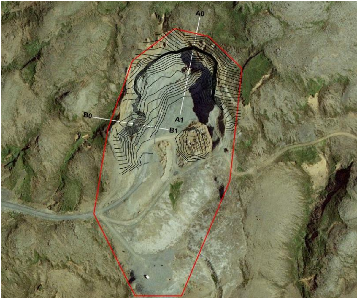
Mynd 6. Yfirlitsmynd af námunni og staðsetning þversniða. Rauða línan sýnir útmörk efnistökkunnar. Hæðarlínur sýna hæð í landi efnistökkunnar eins og hún er núna.
