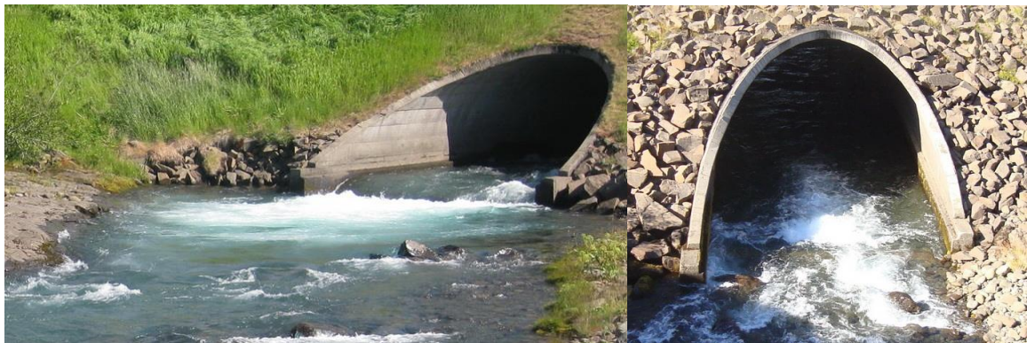
Mynd 4.2.2.11: Ræsi undir Þjóðveg.
